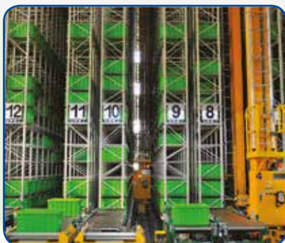
Magazzino Automatizzato Automated warehousing
