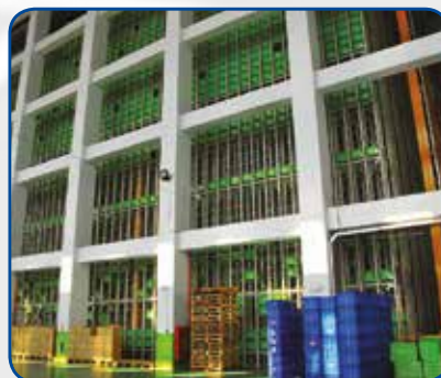
Magazzino Automatizzato High capacity warehousing
